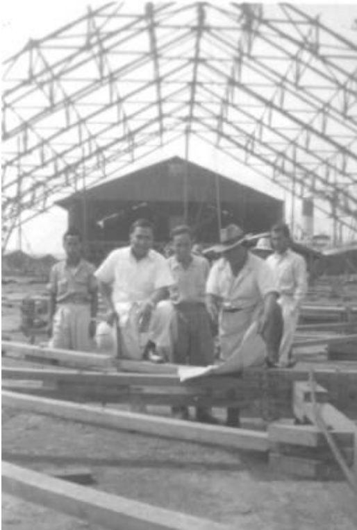
Nr.0005: Loods in Tandjung Priok Plaats: Djakarta
