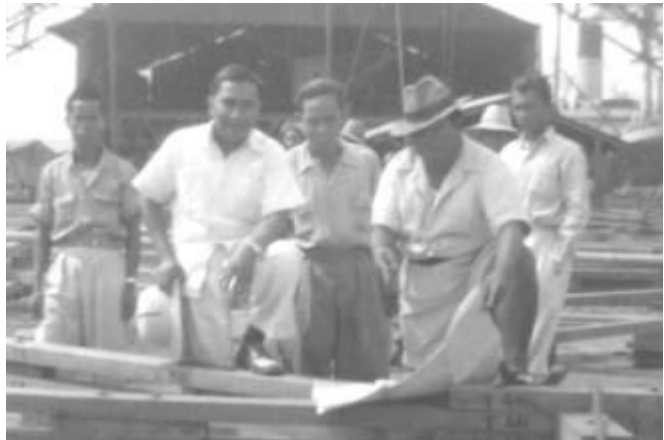
Nr.0006: Loods in Tandjung Priok Plaats: Djakarta
